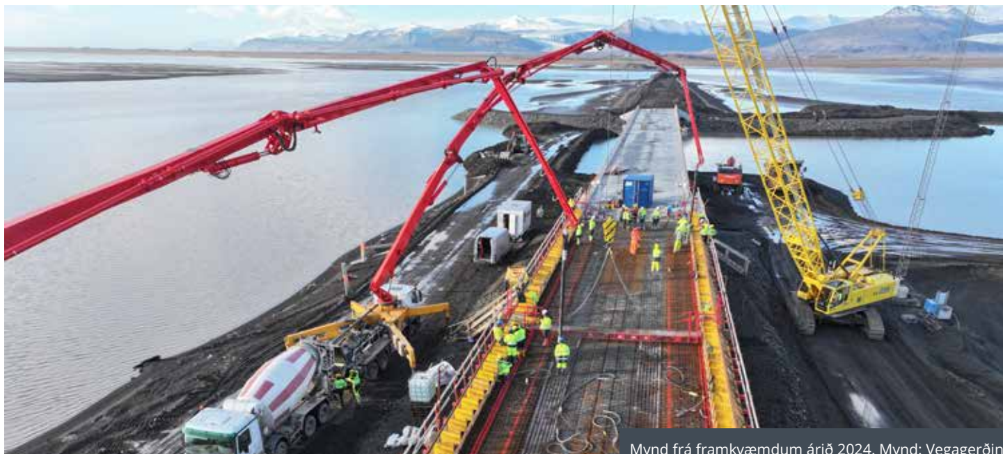
Mynd frá framkvæmdum árið 2024. Mynd: Vegagerðin
