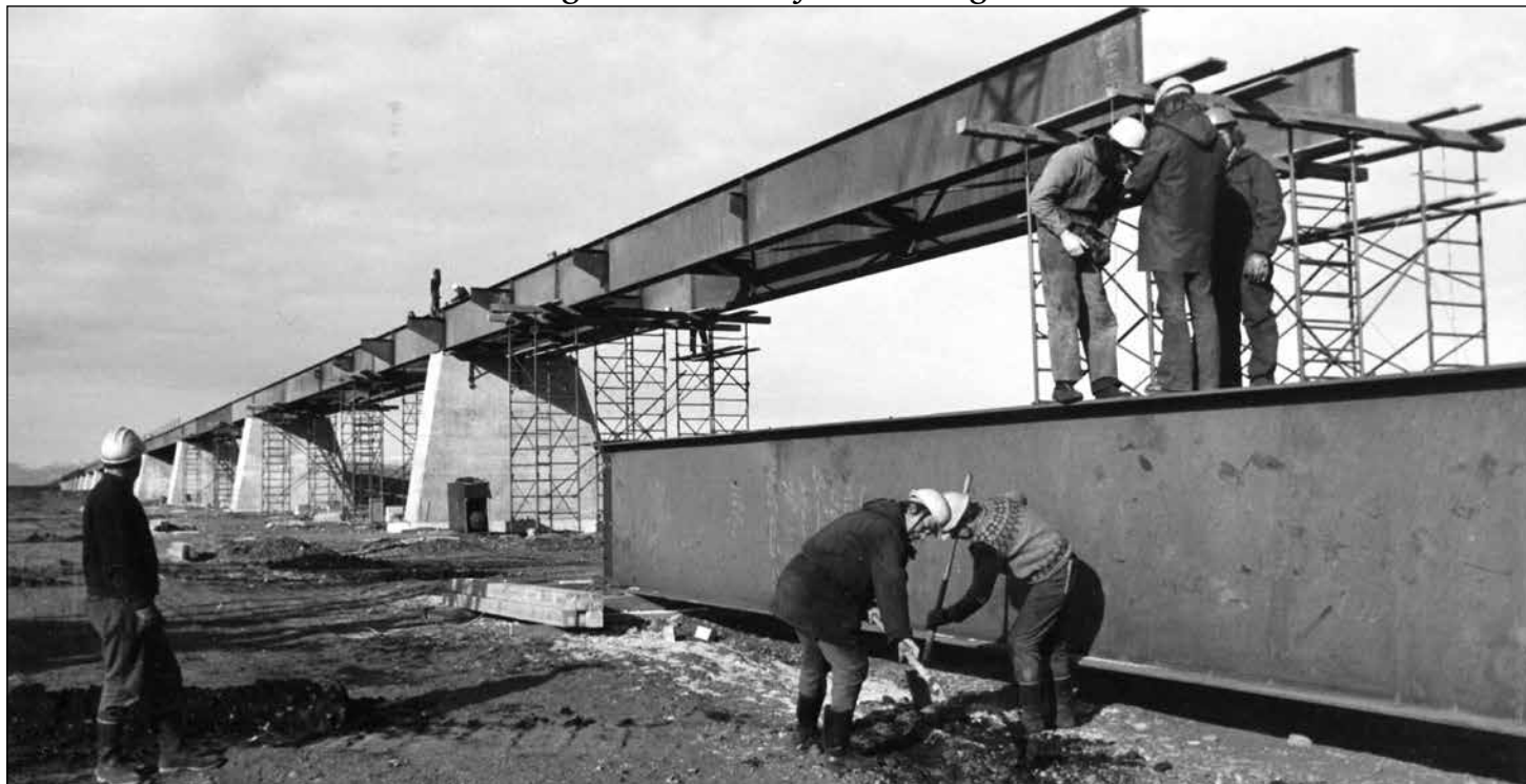
Frá byggingu á Skeiðarárbrú 1972-1974. Mynd: Vegagerðin
